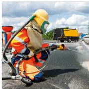
Viele Anwendungen der Oberflächenvorbereitung und -reinigung sind auf Druckluft angewiesen, z. B. Sand- und Trockeneisstrahlen. Für maximale Produktivität und Langlebigkeit der Geräte erfordern diese speziellen Anwendungen eine konstante Versorgung mit kühler, kondensatfreier und technisch ölfreier Druckluft, die den Anforderungen an Druck und Liefermenge konstant entspricht.
