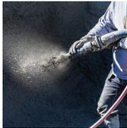
Druckluft ist für eine gute Betonverdichtung beim Spritzbetonieren und Betonrütteln von zentraler Bedeutung. Um ein optimales Ergebnis zu erzielen, muss die Druckluftversorgung den erforderlichen Druck und Luftstrom zuverlässig liefern und kühler, kondensatfreier Druckluft liefern. Beim Spritzbetonieren wird zusätzlich technisch ölfreie Luft benötigt.
