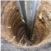
Die Bauvorbereitung großer Bauwerke beginnt in der Regel mit geotechnischen Bohrungen zur Beurteilung des Untergrunds. Druckluft wird benötigt, um das Bohren an die Oberfläche zu befördern, ein Prozess, der als Spülung bezeichnet wird. Kommt das Imlochhammerbohrverfahren (OTH-Bohren) zum Einsatz, wird häufig Druckluft für den Betrieb des Bohrers benötigt.
