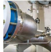
Der gesamte Ablauf einer Kläranlage, wie z. B. die Einstellung von Ventilen, Schiebern und Klappen, wird häufig von pneumatischen Stelltriebselementen, die eine präzise Steuerung ermöglichen. In einigen Fällen spielt das Druckluftnetz auch luftbetrieblene Pumpen und wird für die Schlammabtrennung verwendet.
