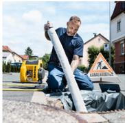
Bei der grabenlosen Kanalanterung wird Druckluft in großem Umfang eingesetzt: Aufblasen von Kanalschüssen, Antrieb von Druckfrähsen zum Einbringen von Baumwurzeln, Entressen von Hühnern in Rohre sowie Kühlung der UV-Lampen, die zum Aushärten des Auskleidungsmaterials verwendet werden.
