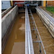
Beim Einsatz eines belüfteten Systems zur Sandentfernung in Kläranlagen sind zuverlässige und effiziente Gebläse erforderlich. In den Sandfängen werden mineralische Bestandteile, wie Sand und Kies, abgetrennt, die über das Abwasser zur Kläranlage gelangen.
