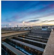
Wenn das Abwasser bestimmte Qualitätsnormen oder Umweltschranken für die Wiederverwendung oder Einleitung erfüllen muss, wird das Wasser in der Regel gefiltert. Um die Qualität des gefilterten Wassers aufrechtzuerhalten, wird häufig eine kontinuierliche oder halbkontinuierliche Filtrerrückspülung als Teil des Filtrationsprozesses eingesetzt. Je nach Technologie kann ein hoher oder niedriger Luftdruck erforderlich sein.
