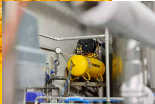
Bryggeriet Friedmann har i mange år bygget på trykluft fra stempelkompressorer fra virksomheden KAESER.
