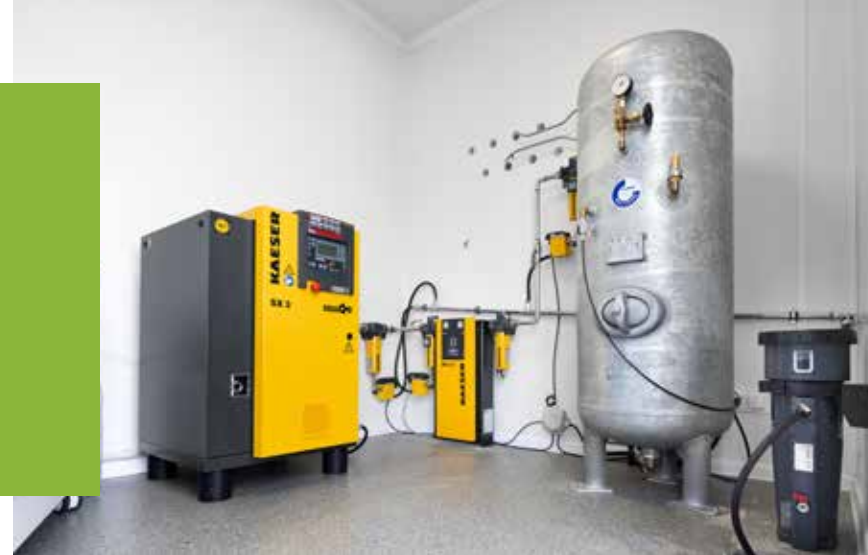
SX 3-skruekompressoren leveres med et avanceret trykluftbehandlingssystem samt en 250-liters trykluftbeholder.
