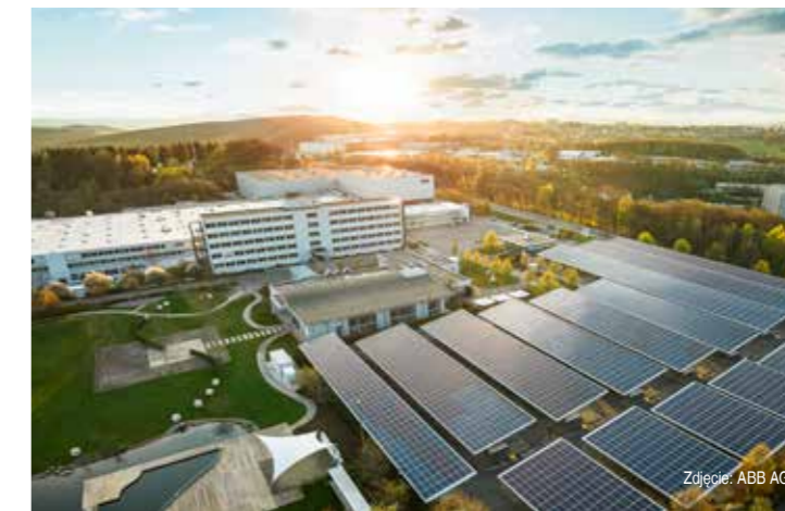
Zdjęcie po lewej: Nowa sprężarka śrubowa CSDX 175 SFC z regulacją częstotliwości spełnia wymagania dotyczące sprawności systemu IES2. Zdjęcie po prawej stronie: Nowa instalacja fotowoltaiczna zapewnia rocznie około 1100 MWh energii elektrycznej wytwarzanej w sposób neutralny dla klimatu.
