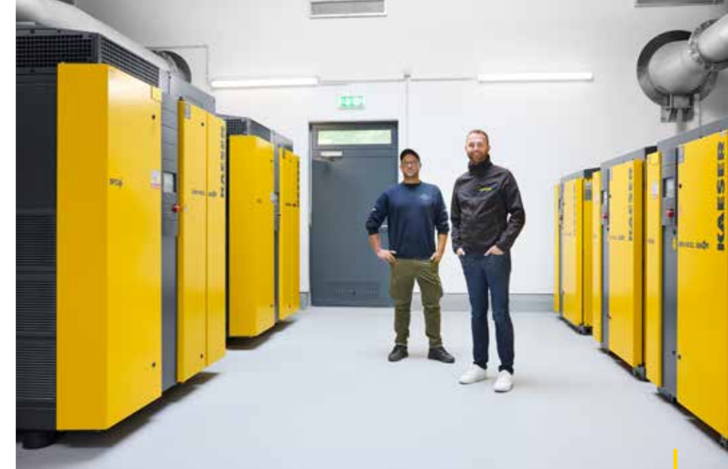
Zdjęcie po prawej stronie: Ogółem pięć dmuchaw śrubowych marki KAESER z regulacją częstotliwości zasila powietrzem osadnik na osad czynny. Z przodu: Florian Utz (kierownik oczyszczalni ścieków w Forchheim), Matthias Sienerth (inżynier ds. sprzedaży w firmie KAESER KOMPRESSOREN).
