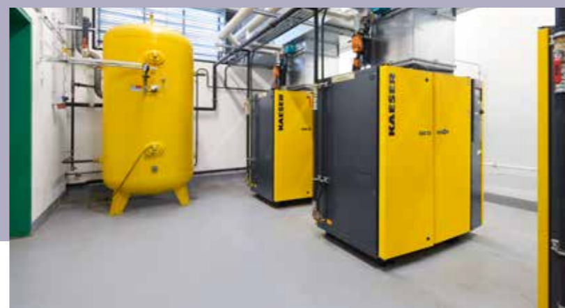
היעד של השגת נצילות אנרגטית מרבית הושג באמצעות בחירה בשלושה מדחסים בורגיים מדגם ASD 35 הכוללים מערכת למחזור חום.
