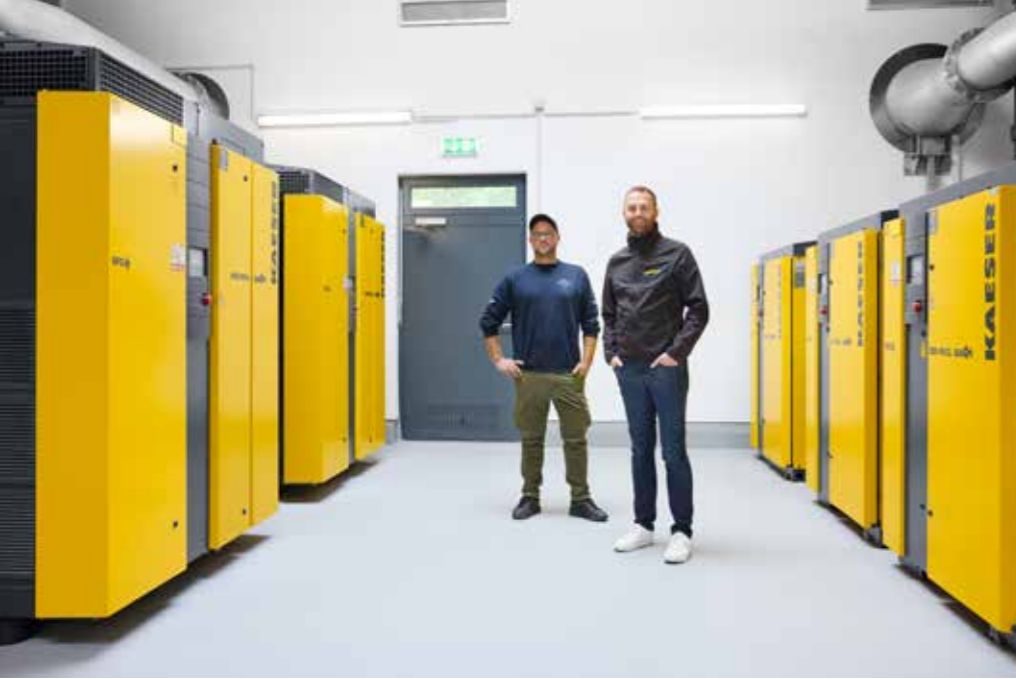
התמונה למעלה: בקר ה-SIGMA AIR MANAGER פועל בתיאום מושלם עם מערכת בקרת התהליך. התמונה מימין: מערך של חמישה מפוחים בורגיים מבית KAESER בעלי מהירות משתנה המזינים את בריכות הבוצה. בחזית: Florian Utz (מנהל התפעול, Forchheim) ו-Matthias Sienerth (מהנדס מכירות, KAESER).
