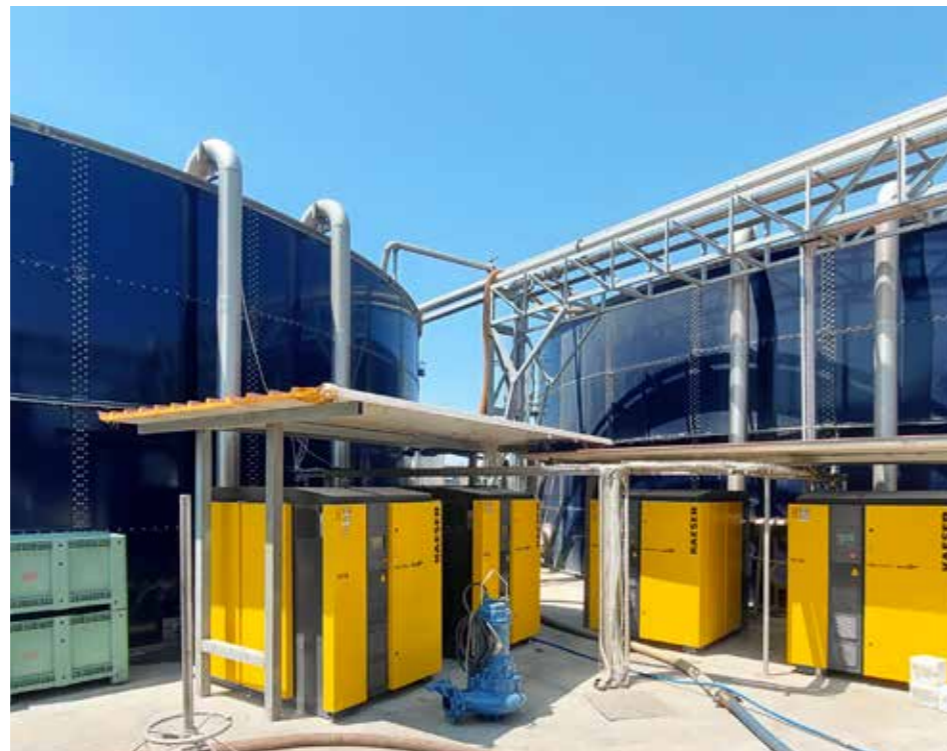
"מפוחי הבורגיים KAESER FBS כוללים מנועי IE5 בעלי נצילות Ultra Premium Efficiency ופרופיל SIGMA PROFILE המותאם ספציפית לשימוש במפוחים, ומעניקים רמת יעילות גבוהה בהרבה."
