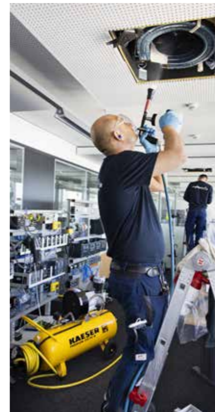
Vlevo: Nákladní vozidlo Eisschmitt přepravuje kompresor MOBILAIR a potřebná zařízení pro tryskání suchým ledem. Vpravo: Využití v závodě KAESER Coburg: čištění ventilačních kanálů.
