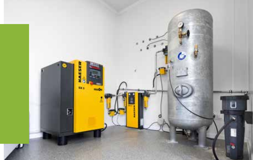
Součástí šroubového kompresoru typu SX 3 je sofistikovaný systém úpravy stlačeného vzduchu a 250litrový vzdušník.
