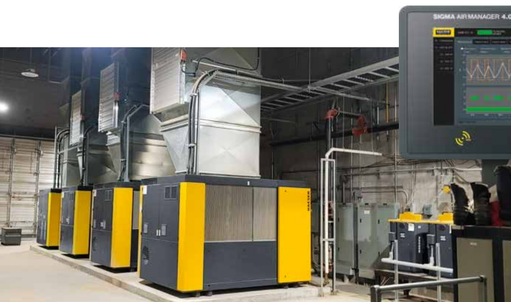
Šroubový kompresor s regulací frekvence pokrývá dočasné špičky, zatímco dva šroubové kompresory s pevným počtem otáček pokryjí základní zatížení.
