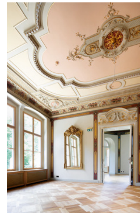
Stuklofterne og væg- og loftsmalingen i hele huset måtte blottægges og sættes i stand.
