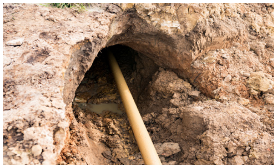
Meget arbejde uden gravning kræver trykluft til reparation, udskiftning og installation af underjordiske forsyningsledninger.
