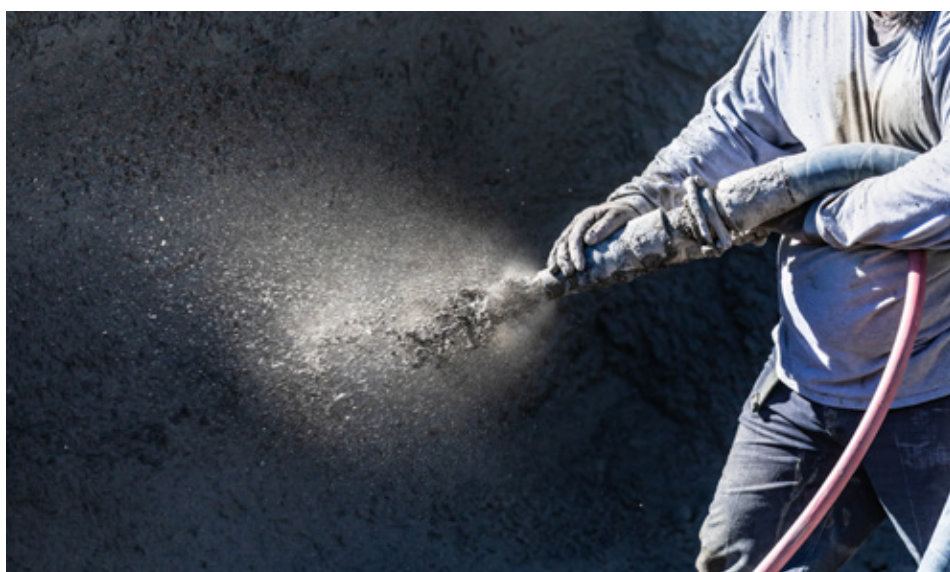
Trykluft anvendes ofte i indsætnings- og efterbehandlingsfasen af betoninstallation og spiller en afgørende rolle for god komprimering.
