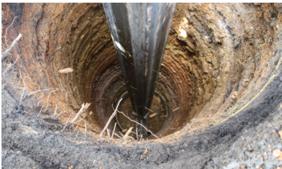
Geotekniske borer kræver trykluft til skylning.
