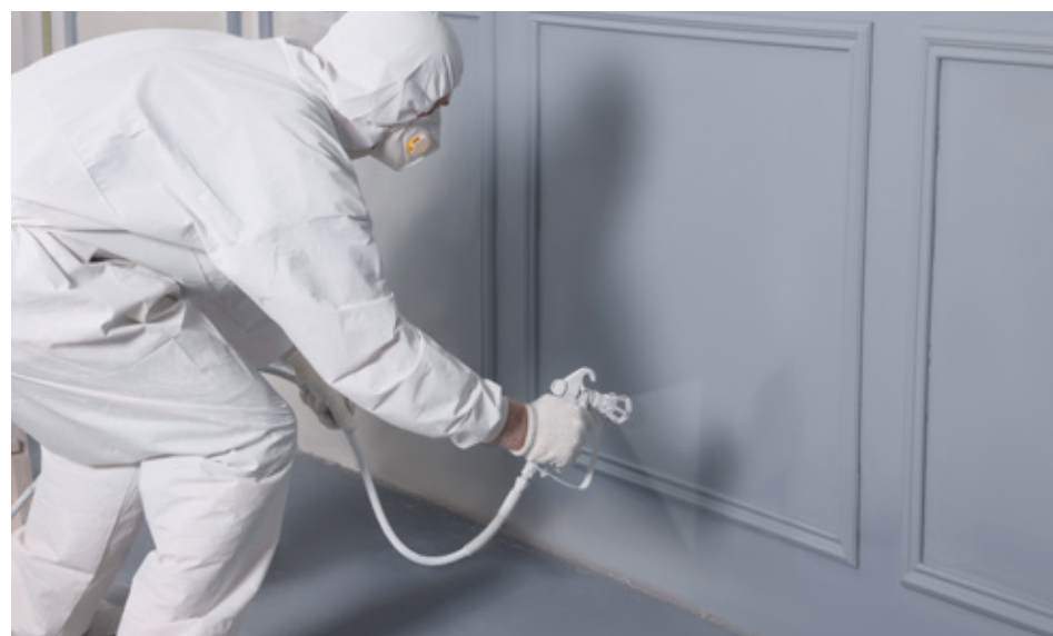
En traditionel sprøjtepistol anvendes til lakering af overflader.
