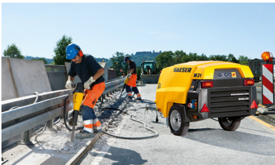
Ved meget nedrivnings- og byggearbejde anvendes trykluftværktøj, der kræver en pålidelig tryklufforsyning til effektiv drift.
