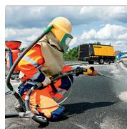
Viele Anwendungen der Oberflächenvorbereitung und -reinigung sind auf Druckluft angewiesen, z. B. Sand- und Stahlkörnerstrahlung. Für industrielle Produktions- und Landwirtschaftlichen Anwendungen werden spezielle Anwendungen der Druckluftversorgung eine konstante Versorgung mit kühler, kondensatfreier und technisch ölfreier Druckluft, die den Anforderungen an Druck und Liefermenge konstant entspricht.
