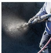
Druckluft ist für eine gute Betonverarbeitung beim Spritzbetonieren und Bettelnötigen von zentraler Bedeutung. Um ein optimales Ergebnis zu erhalten, muss die Druckluft eine optimale Temperatur, Druck und Luftstrom zuverlässig erfüllen und kühle, kondensatfreie Druckluft liefern. Beim Spritzbetonieren wird zusätzlich technisch ölfreie Luft benötigt.
