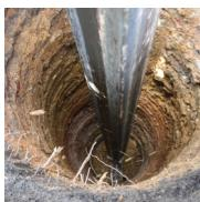
Die Bauvorbereitung großer Bauwerke beginnt in der Regel mit geotechnischen Bohrungen, zur Beurteilung des Untergrunds und um die Böschungen zu stabilisieren, um das Bauwerk an die Oberfläche zu befähigen. Der Prozess, der als Spülung bezeichnet wird, kommt das Imlochhammerbohrverfahren (DTB-Bohren) zum Einsatz, wird häufig Druckluft für den Betrieb des Bohwers benötigt.
