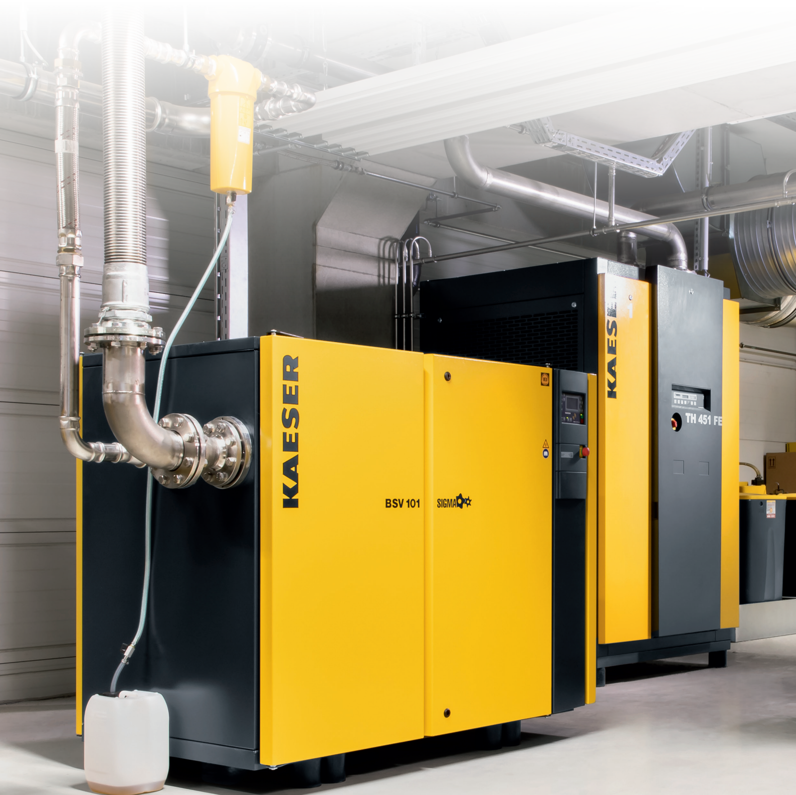
Imagen: Estación de vacío con BSV 101
