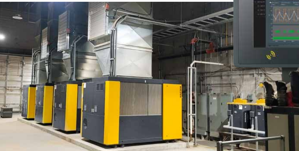
O compressor de parafuso com regulação de frequência cobre os picos de consumo, enquanto os três compressores de parafuso com velocidade fixa cobrem o consumo base.
