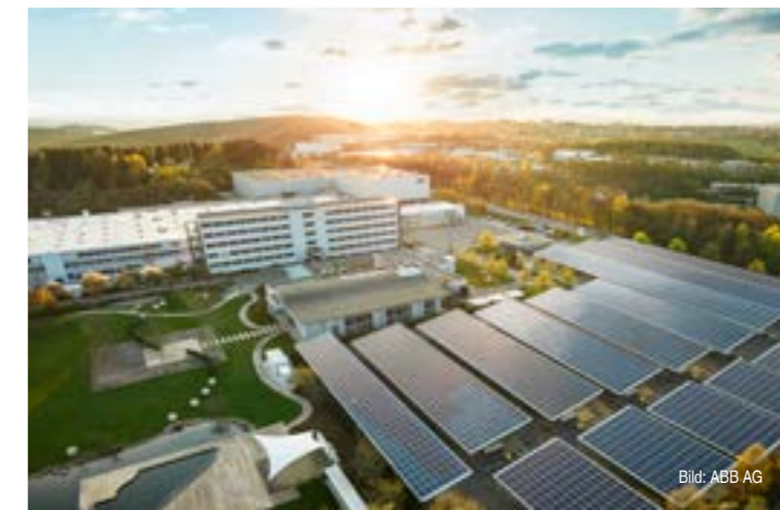
Bild links: Der neue, frequenzgeregelte Schraubenkompressor CSDX 175 SFC erfüllt den Systemwirkungsgrad IES2. Bild rechts: Die neue Photovoltaikanlage liefert pro Jahr rund 1.100 MWh klimaneutralen Strom.
