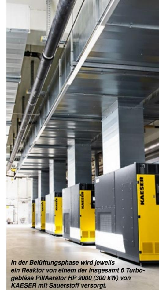
In der Belüftungsphase wird jeweils ein Reaktor von einem der insgesamt 6 Turbogebälse Pillaerator HP 9000 (300 kW) von KAESER mit Sauerstoff versorgt.
