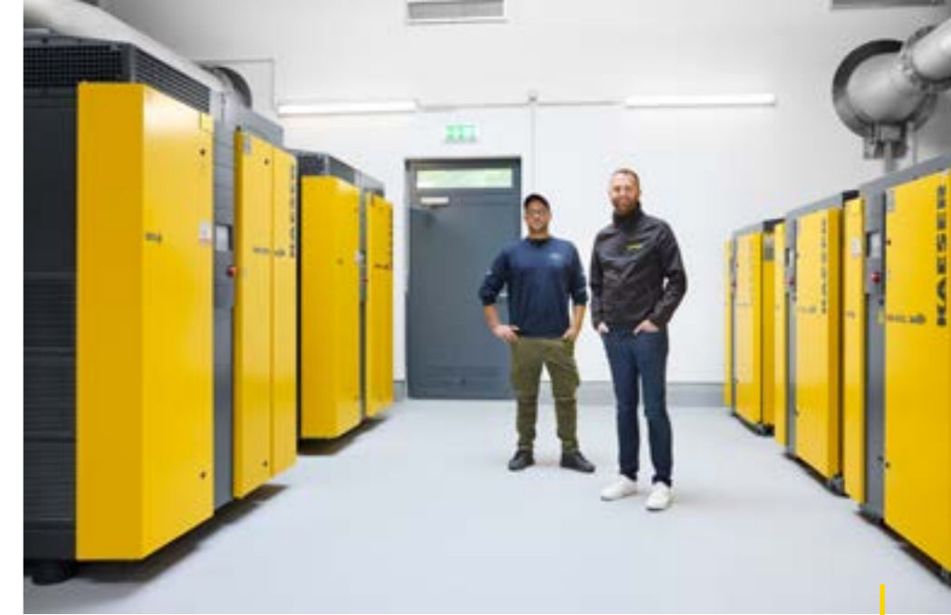
Bild oben: Der SIGMA AIR MANAGER 4.0 arbeitet in perfekter Harmonie mit der Prozessleittechnik. Bild rechts: Insgesamt fünf frequenzgeregelte KAESER-Schraubengebläse fördern die Luft für das Belebungsbecken. Davor: Florian Utz (Betriebsleiter Kläranlage Forchheim), Matthias Sienarth (Vertriebsingenieur KAESER).
