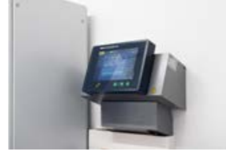
Bild oben: Der SIGMA AIR MANAGER 4.0 arbeitet in perfekter Harmonie mit der Prozessleittechnik. Bild rechts: Insgesamt fünf frequenzgeregelte KAESER-Schraubengebläse fördern die Luft für das Belebungsbecken. Davor: Florian Utz (Betriebsleiter Kläranlage Forchheim), Matthias Sienarth (Vertriebsingenieur KAESER).
