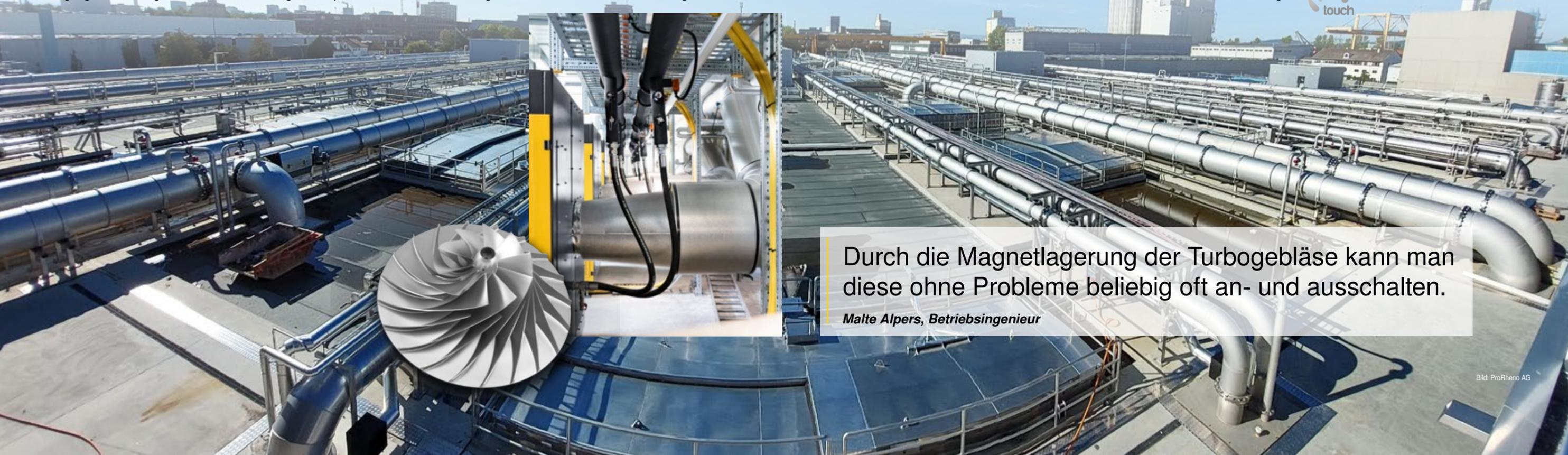
Durch die Magnetlagerung der Turbogebälse kann man diese ohne Probleme beliebig oft an- und ausschalten.
