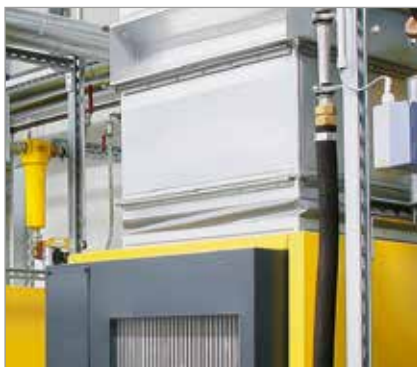
2. ábra: Kompresszorok szellőztetésének csatlakoztatása szövetkompenzátor segítségével
