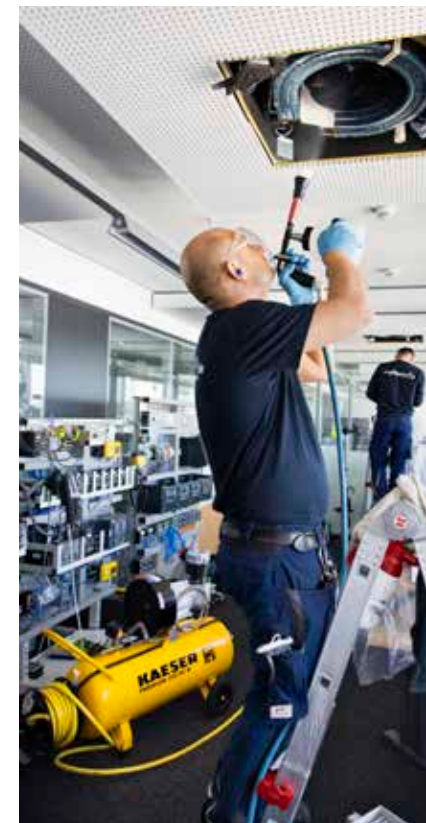
À gauche : le camion Eisschmitt transporte le compresseur MOBILAIR et les installations de projection de glace carbonique nécessaires. À droite : intervention sur le site de KAESER à Cobourg pour le nettoyage des gaines de ventilation.
