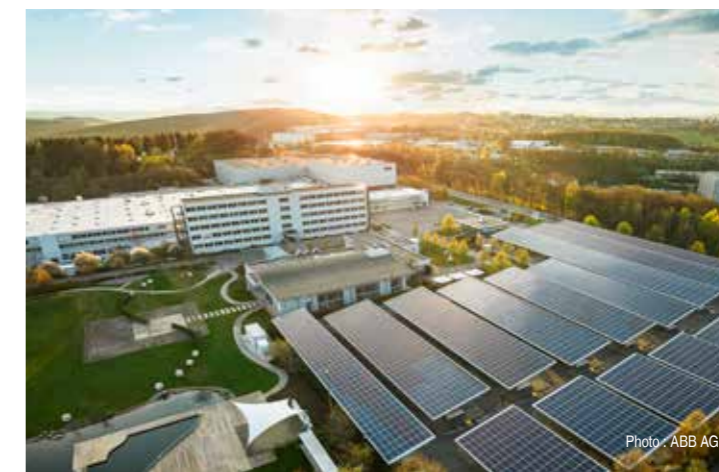
Photo de gauche : le nouveau compresseur à vis à variation de vitesse CSDX 175 SFC atteint le rendement global IES2. Photo de droite : la nouvelle installation photovoltaïque produit environ 1 100 MWh d'électricité climatiquement neutre par an.
