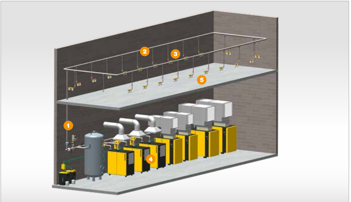
Afb. 1: Hoofdcomponenten van een persluchtverdeelstelsel: hoofdleiding (1), verdeelleiding (2), aansluitleiding (3), droger (4), onderhoudseenheid/slang (5)
