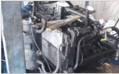
Afb. 1: Verwaarloosd persluchtstation
