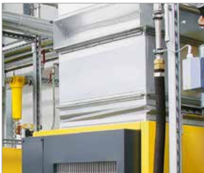
Afb. 2: Ventilatieaansluiting van de compressor met elastische verbinding
