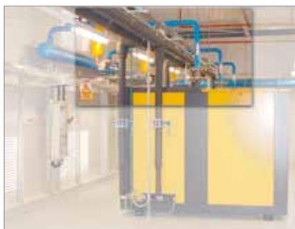
Afb. 3b: Trillingselastische compressoraansluiting met axiale compensatoren
