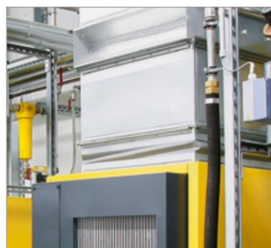
Fig. 2 : Raccordement du gainage par un manchon en toile
