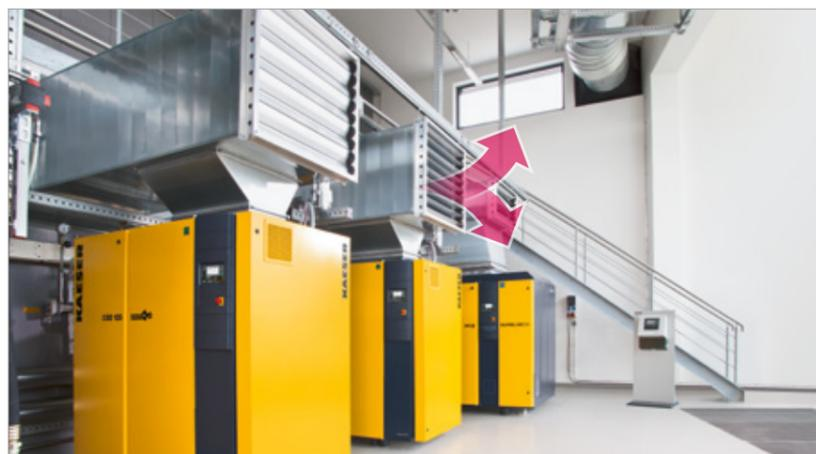
Fig. 3 : Station d'air comprimé avec une ventilation thermostatée
