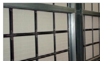
Fig. 2b : Système de filtration de l'air de refroidissement
