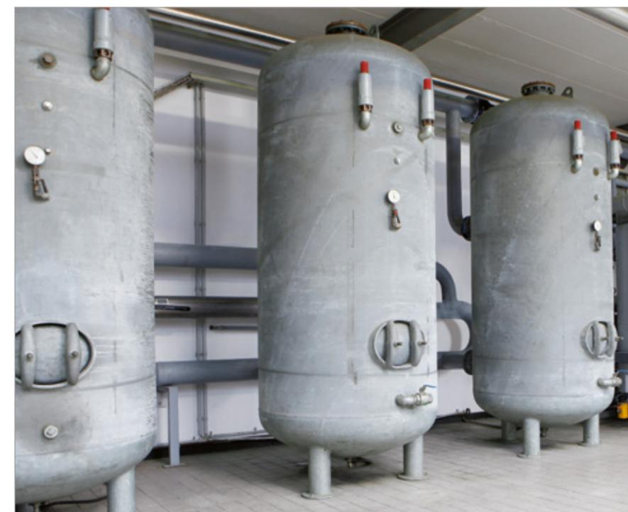
Fig. 4 : Réservoir d'air comprimé servant de volume tampon
