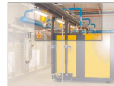
Fig. 3b : Raccordement du compresseur avec un compensateur axial
