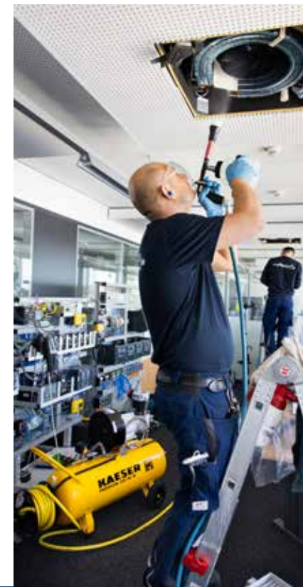
Links: Der Eisschmitt-Truck transportiert den MOBILAIR-Kompressor und die benötigten Trockeneisstrahlanlagen. Rechts: Einsatz am KAESER-Standort Coburg: Reinigung der Lüftungskanäle.
