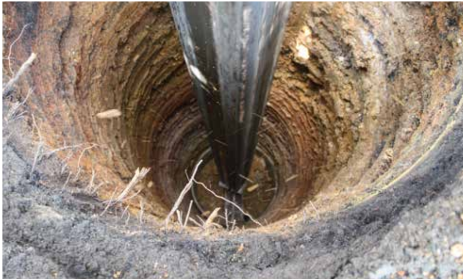
Geotechnische Bohrungen erfordern Druckluft zum Spülen.
