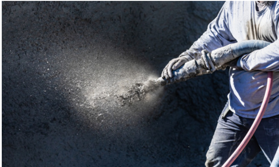
Druckluft wird häufig in der Einbringungs- und Nachbearbeitungsphase beim Betoneinbau eingesetzt und spielt eine entscheidende Rolle für eine gute Verdichtung.
