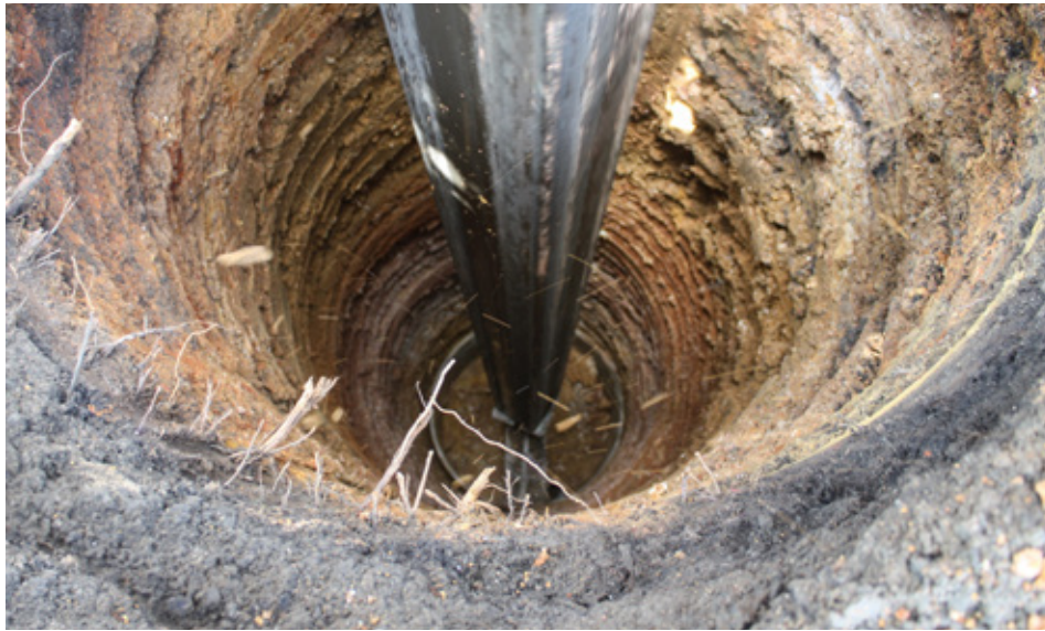
Geotechnische Bohrungen erfordern Druckluft zum Spülen.
