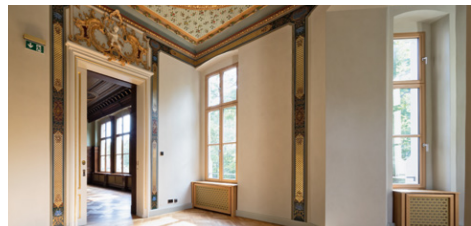
Der Holzboden wurden von einem Handwerkerfachbetrieb überarbeitet und teilweise erneuert.
