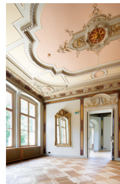
Die Stuckdecken sowie Wand- und Deckenbemalungen im ganzen Haus mussten freigelegt und instandgesetzt werden.
