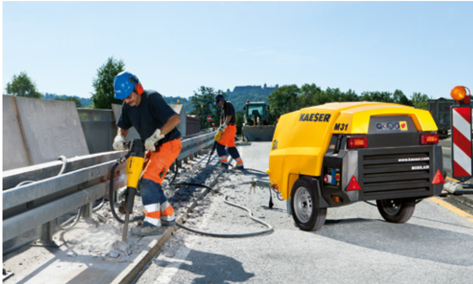
Bei vielen Abbruch- und Bauarbeiten werden Druckluftwerkzeuge eingesetzt, die für einen effektiven Betrieb eine zuverlässige Druckluftversorgung benötigen.
