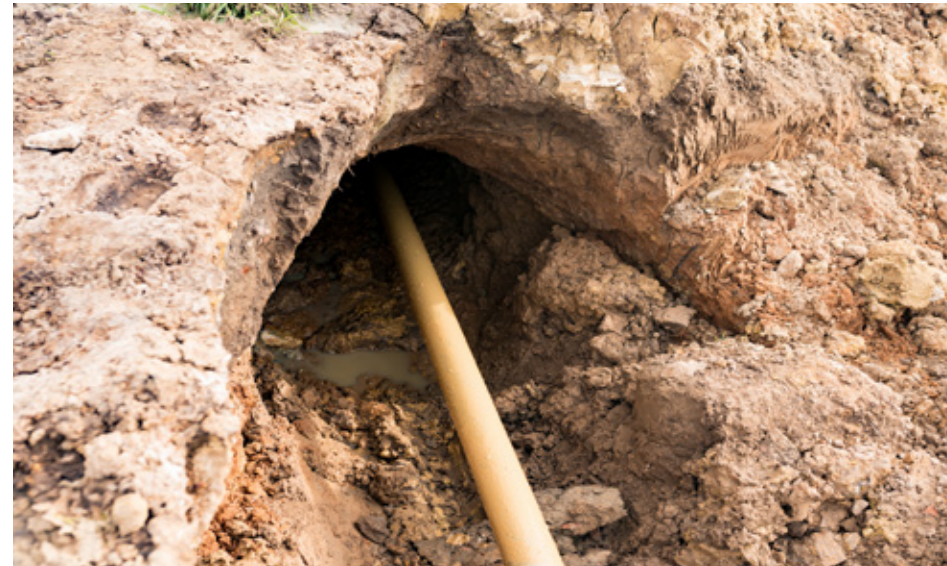
Viele grabenlose Arbeiten erfordern Druckluft für die Reparatur, den Austausch und die Installation unterirdischer Versorgungsleitungen.
