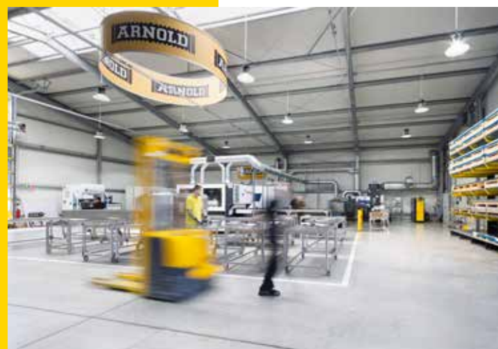
Chez Arnold, pratiquement chaque étape du processus repose sur un approvisionnement en air comprimé parfaitement fiable et de haute qualité.
