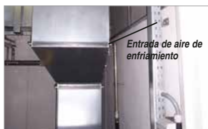
Imagen 2a: Esterillas filtrantes centralizadas del aire de enfriamiento.
