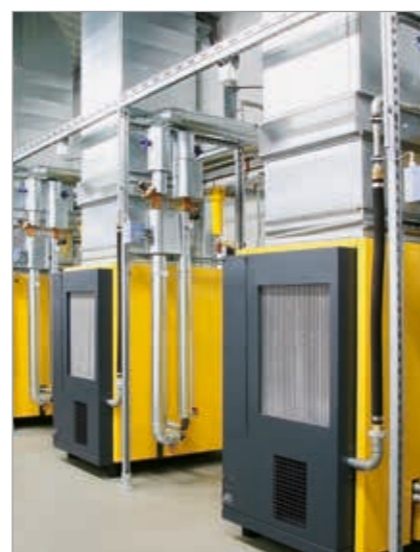
Imagen 2: Conexión de varios compresores a un sistema de recuperación del calor conforme a la normativa.
