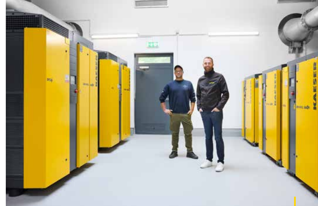
Slika zgoraj: SIGMA AIR MANAGER 4.0 deluje v popolni harmoniji s tehnologijo krmiljenja procesov. Slika desno: Skupaj pet frekvenčno krmiljenih vijačnih puhal KAESER dovaja zrak za bazen za poživiljanje. Spredaj: Florian Utz (vodja obratovanja, čistilna naprava v Forchheimu), Matthias Sienerth (prodajni inženir, KAESER).
