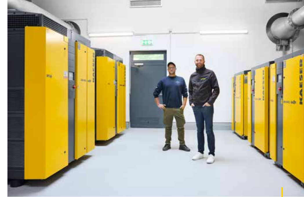
Fenti kép: A SIGMA AIR MANAGER 4.0 tökéletes összhangban működik a folyamatirányítási technológiával. Jobb oldali kép: Összesen öt frekvenciaszabályzott KAESER csavarfúvó szállítja a levegőt a levegőztetőmedencéhez. Előttük áll: Florian Utz (a forchheimi szennyvíztisztító telep üzemvezetője) és Matthias Sienerth (a KAESER értékesítési mérnöke).
