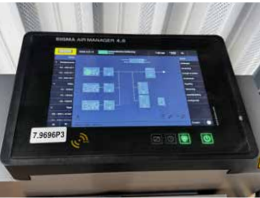
El SIGMA AIR MANAGER 4.0 procura un funcionamiento eficiente y un reparto homogéneo de la carga entre todos los compresores.
