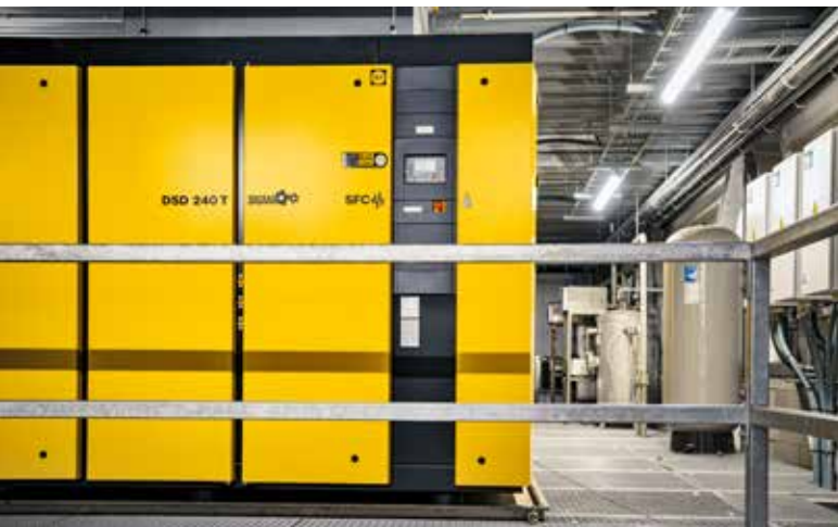
Kolme taajuussäädettyä DSD 240 T SFC -ruuvikompressoria integroiduilla kuivaimilla varustettuina huolehtivat yrityksen luotettavasta paineilmajärjestelmästä.
